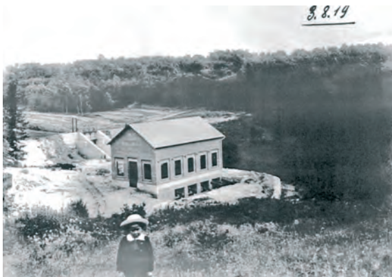
À gauche, un aperçu des travaux du barrage vers 1919, à droite, un baigneur s'élanche de la digue © ASIS.
